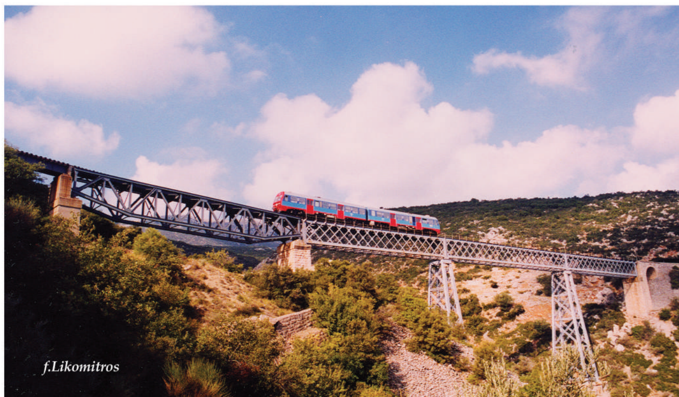
ΓΕΦΥΡΑ ΕΛΑΙΟΧΩΡΙΟΥ ΑΡΚΑΔΙΑΣ - BRIDGE OF ELEOCHORIO ARCADIA
