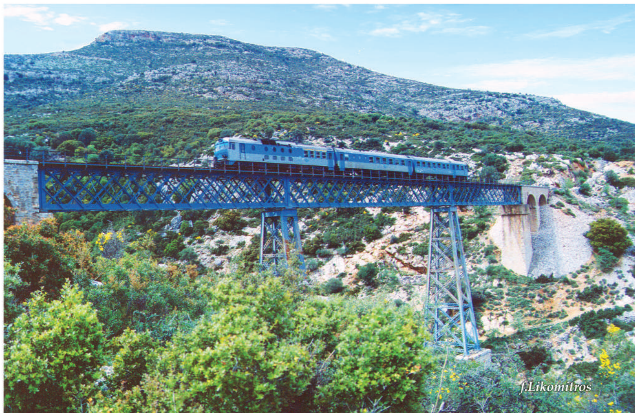
ΓΕΦΥΡΑ ΠΑΡΘΕΝΙΟΥ ΠΕΡΙΟΧΗ ΑΧΛΑΔΟΚΑΜΠΟΥ - PARTHENIΟΥ BRIDGE, AREA ACHLADOKAMBOU
