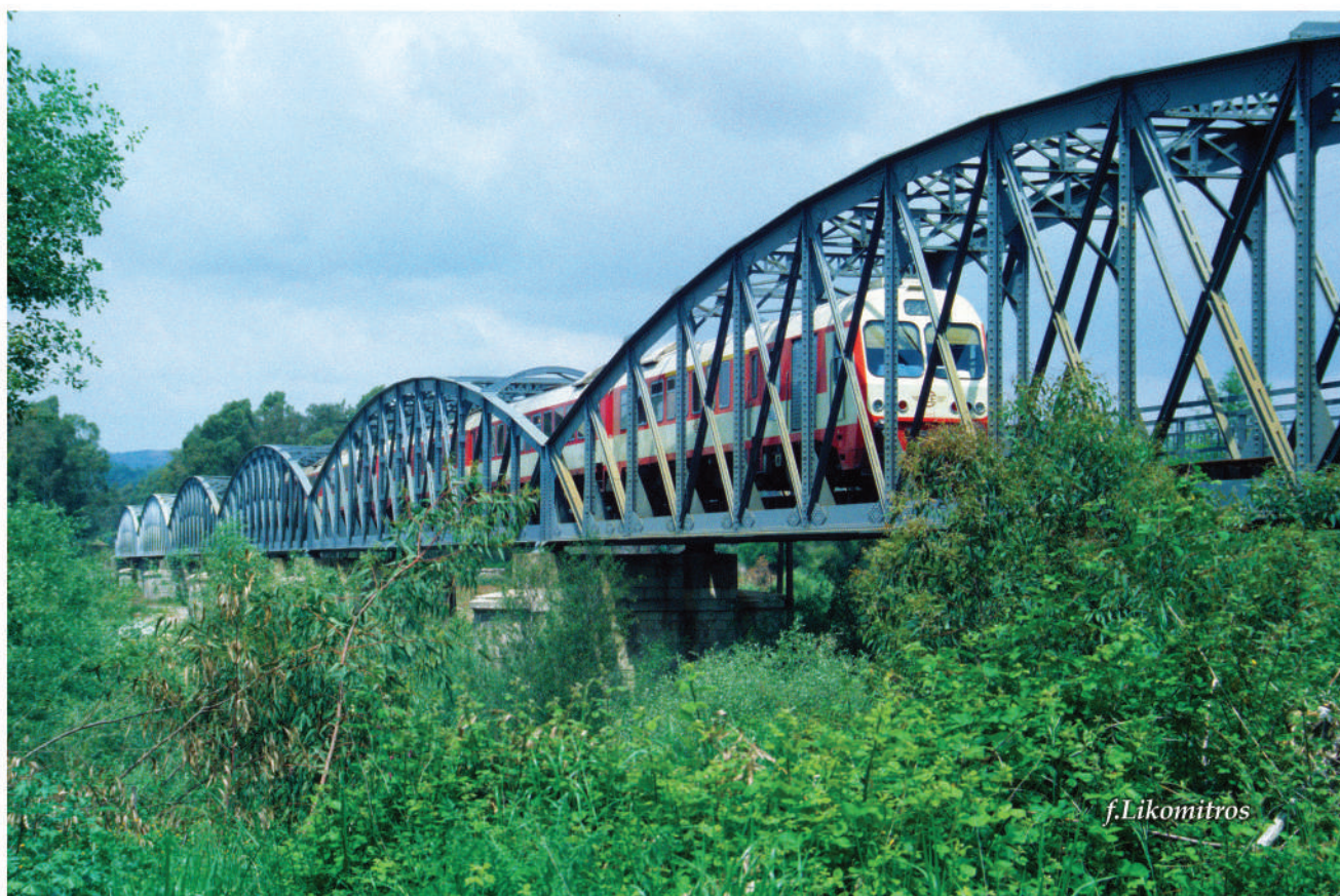
ΓΕΦΥΡΑ ΑΛΦΕΙΟΥ Ν. ΗΛΕΙΑΣ - ALFIOS BRIDGE ILIAS
