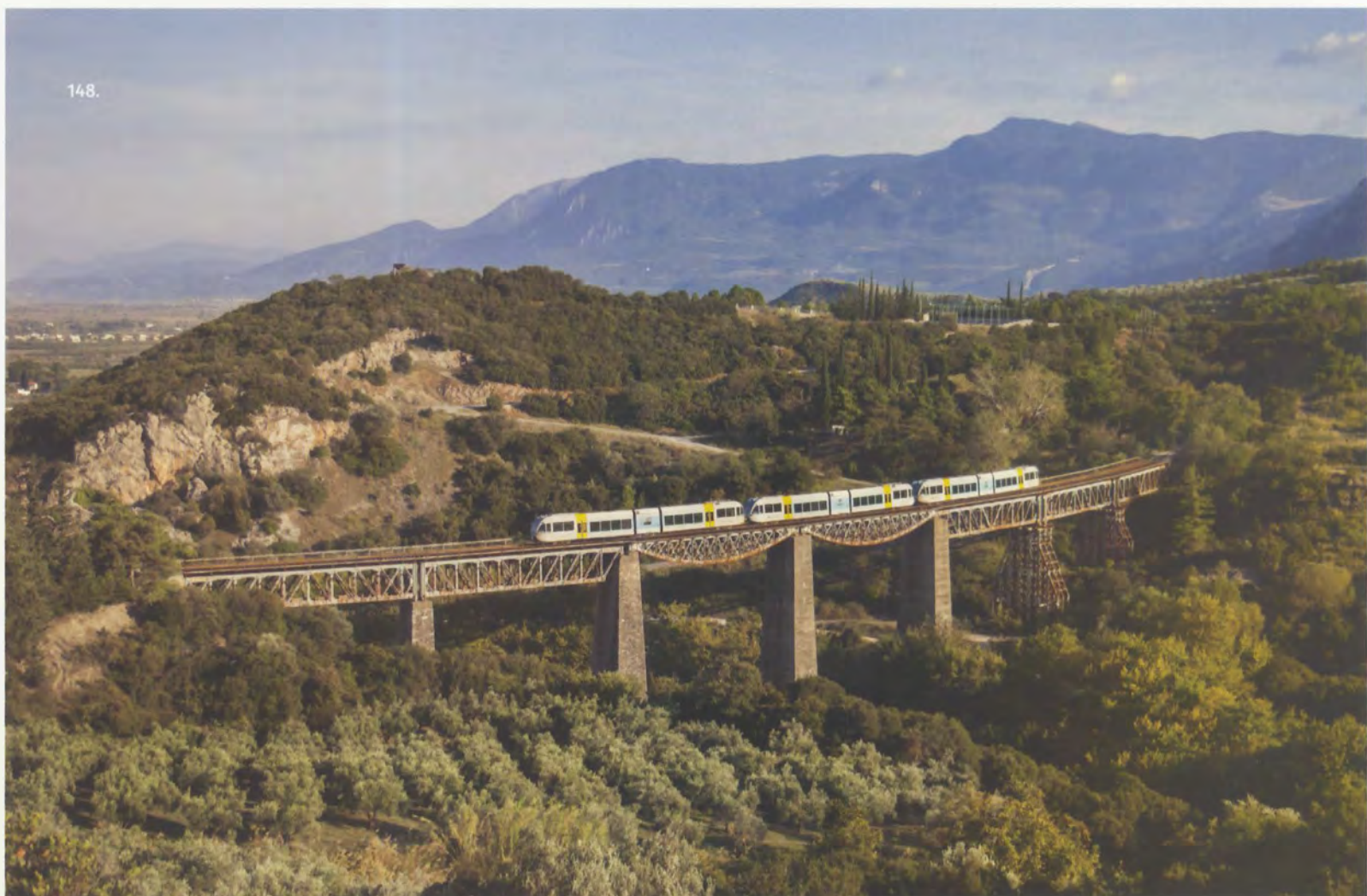
147. & 148. / Λόγω της αστάθειας των εδαφών στο σημείο αυτό, οι κατασκευαστές αντιμετώπισαν σοβαρότατα προβλήματα στήριξης της γέφυρας για τέσσερα σχεδόν χρόνια. 24.9.2011 Π. Κάσσαρης, 15.10.2017 Α. Σικαλιάς.
