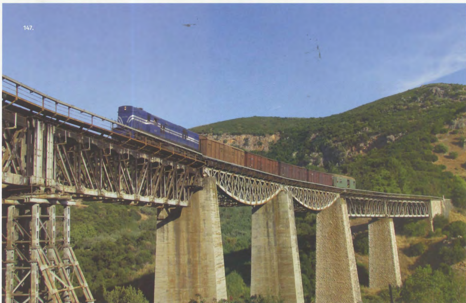
147. & 148. / Λόγω της αστάθειας των εδαφών στο σημείο αυτό, οι κατασκευαστές αντιμετώπισαν σοβαρότατα προβλήματα στήριξης της γέφυρας για τέσσερα σχεδόν χρόνια. 24.9.2011 Π. Κάσσαρης, 15.10.2017 Α. Σικαλιάς.
