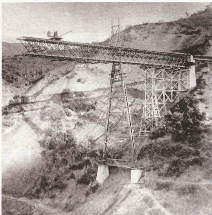
Σ. | Η κατασκευή της γέφυρας της Παπαδιάς στο προς τον Πειραιά τμήμα της. Φωτογραφία Α. Γαζιάδης, 1906. (συλλογή Σ. Νικολόπουλου). Papadia viaduct: construction of the first part (south) 1906. (N. Gaziadis) (coll. S. Nikolopoulos).
