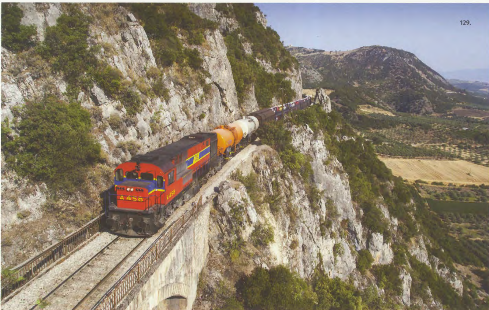
128. & 129. | Στο άκρο της Στάσης Τραχίνας, κοντά στο χωριό Βαρδάτες (χθ. 210+300), ένα κομψό μονότοξο, λίθινο γεφύρι ανοίγματος 12μ. 7.6.2008 Ν. Καντήρης. 20.7.2008. Κ. Κακαβάς.
