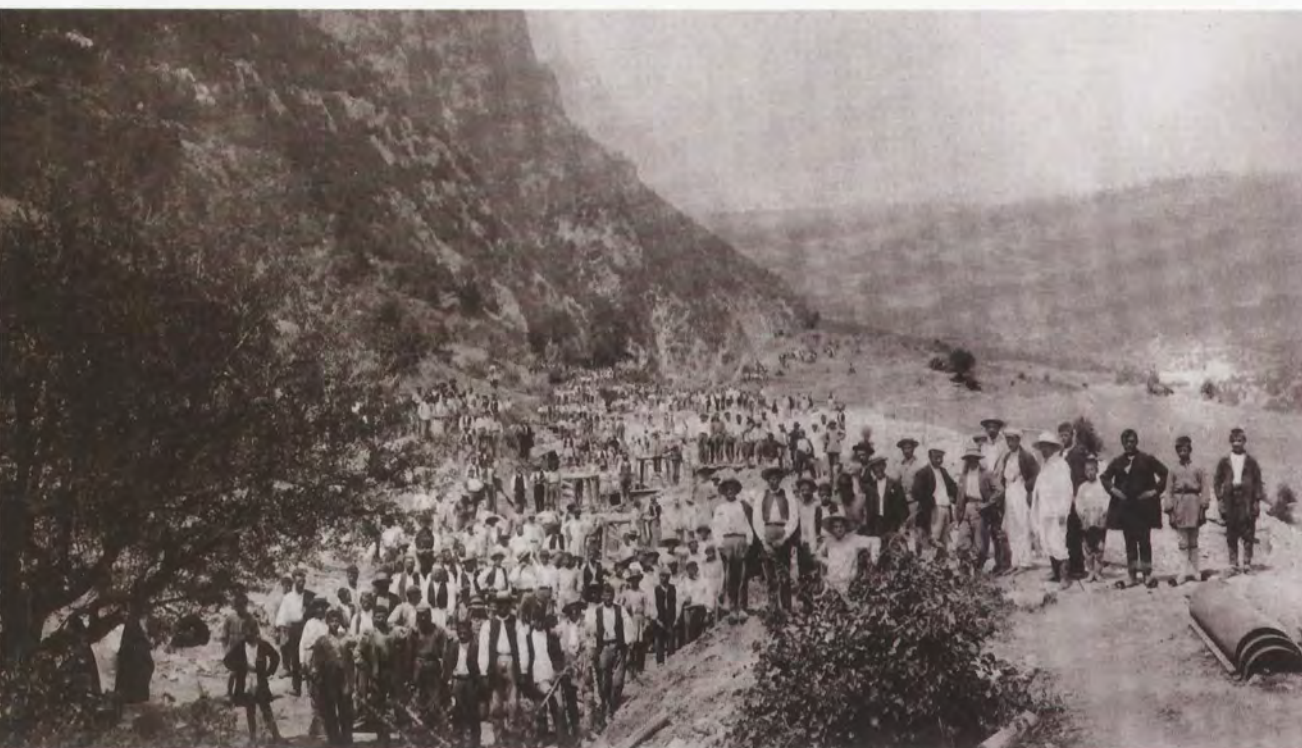
Σ. | Εκατοντάδες εργάτες, ανάμεσα τους και πολλοί Ιταλοί, εργάστηκαν σκληρά στα έργα της περιοχής Μπράλου. Εδώ, κατά την διάρκεια των πρόδρομων εργασιών για την θεμελίωση της γέφυρας Παπαδιάς. Φωτογραφία Γ. Νέλλας, 1906. Hundreds of workers, including many Italians, worked really hard in the construction of the line. Here, excavations for the foundations of Papadia viaduct have just started. 1906 (G. Nellas).
