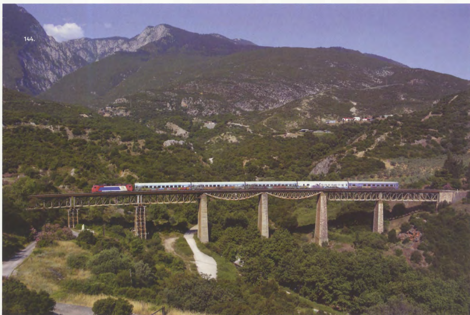
143. & 144. | Γεφυρώνοντας τον Γοργοπόταμο στη χ.θ. 214+720, η καμπυλωτή κατασκευή με τα 6 μεσόβαθρα και 7 μεταλλικά ζευκτά, έχει χάσει την αρχική της μορφή, μετά την ανατίναξη της το 1942 και τη καταστροφή της από τους υποχωρούντες Γερμανούς το 1944. 2.3.2013 Ι. Ζώρζος, 14.6.2015 Γ. Καρυοφύλλης.
