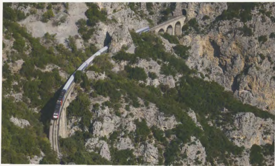
76. & 77. Ι Απο εδώ αρχίζουν τα θαυμαστά επιτεύγματα των μηχανικών που κατασκεύασαν τη γραμμή στις αρχές του 20ου αι. Σκαρφαλωμένα στο γκρεμό τα δύο πρώτα λίθινα γεφύρια στο τμήμα αυτό: το δίτοξο (χ.β. 206-634) και το τριτόξο (χ.β. 206-855), σε πλήρη αρμονία με το τοπίο. 8.9.2006 Κ. Κακαβάς, 15.10.2017, Α. Σκακιάς.
