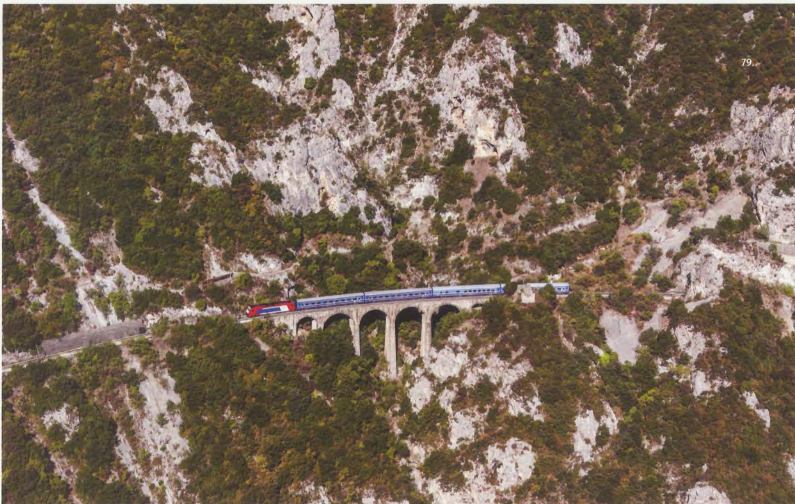
79. – 85. | Το 6τοξο λίθινο γεφύρι, βρίσκεται δίπλα στο «Μονοπάτι των Σιδηροδρομικών» και είναι από τα ένα από τα τοπόσημα της γραμμής, αγαπημένο θέμα των σιδηροδρομικών φωτογράφων στην Ελλάδα. Με μήκος 64μ και ύψος 24μ. διατηρείται αναλλοίωτο στο χρόνο, πάντα όμως αλλάζει μορφή και χρώμα καθώς παίζει ασταμάτητα με το φως, τις εποχές, τα καιρικά φαινόμενα και τα τραίνα που το διασχίζουν, όπως π.χ. το IC52 (8.9.2016 Κ. Κακαβάς) ή ένα ολοκαινούργιο, διπλό Desiro (16.5.2006 Β. Κοροβέσης).
