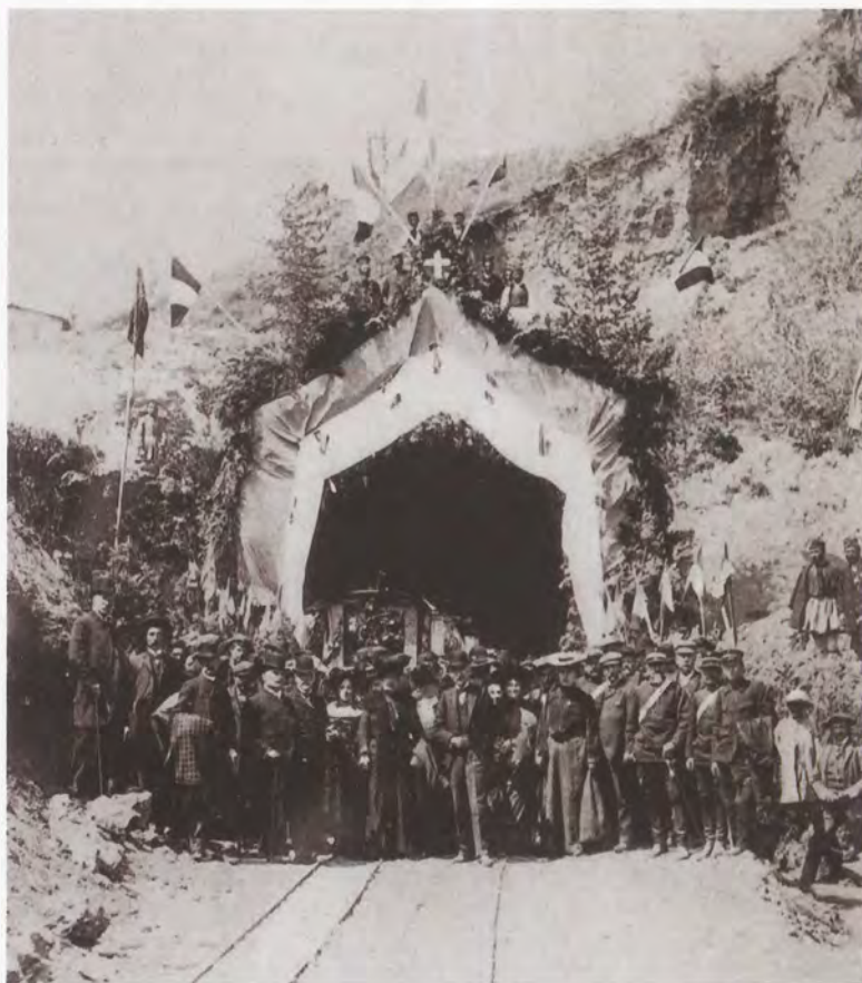
Σ. | Τα πανηγυρικά εγκαίνια της σήραγγας του Μπράλου, στις 4 Απριλίου 1904. Η είσοδος της σήραγγας από την πλευρά της Λαμίας, είναι σηματοδοτισμένη. Στο έδαφος παρατηρούμε τη στενή, εργοταξιακή γραμμή, ενώ μέσα στη σήραγγα διακρίνονται τα στολισμένα αμαξάκια που πρόκειται να μεταφέρουν τους προσκεκλημένους για να διασχίσουν τη στοά. Αρχείο Ν. Δαβανέλλου. Πηγή: Ν. Τσίτσας, «Μπράλος: Το σιδηροδρομικό πέρασμα», σ.55. The official ceremony to celebrate the opening of Bralos Tunnel. 4 April 1904. (N. Tsitsas).
