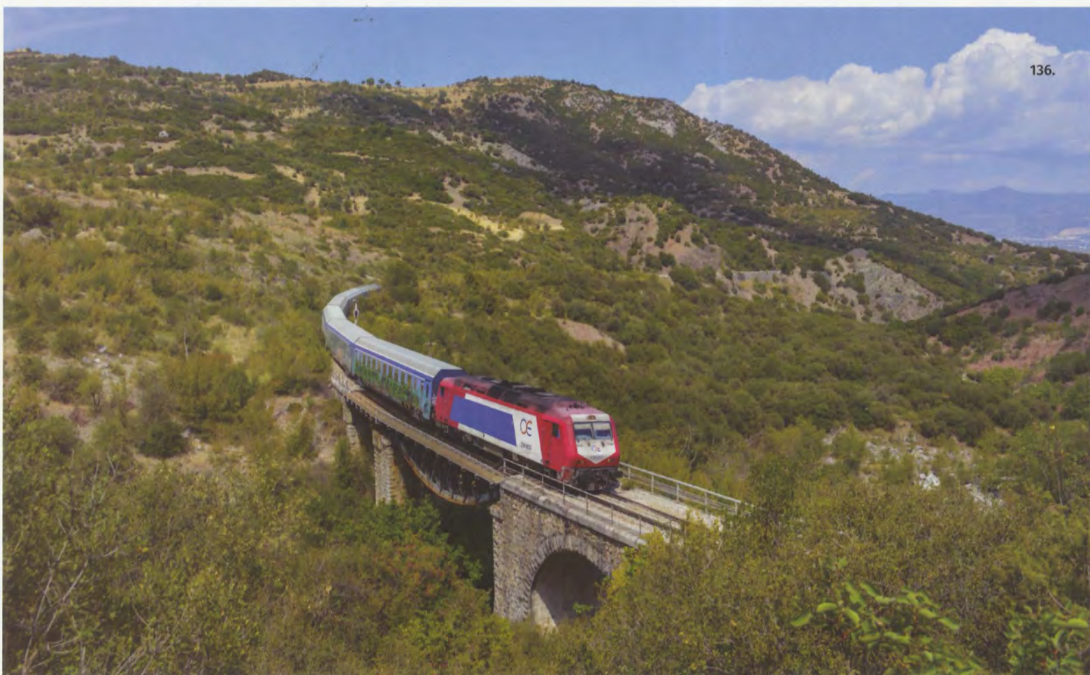
135. - 138. | Μετά την Στάση Τραχίνας, η βραχοπλαγιά της Οίτης χαμηλώνει και το τοπίο γίνεται πιο ανοιχτό και ήπιο. Εδώ κατεβαίνει ο Ξεριάς που για να τον γεφυρώσουν οι μηχανικοί κατασκεύασαν (χθ. 211+202) ένα ακόμη κομψό, καμπυλωτό γεφύρι ανοίγματος 40μ. Αποτελείται από ένα μονό μεταλλικό ζευκτό που αρχικά στηρίζονταν σε δύο αψιδωτά, λίθινα ακρόβαθρα, το βόρειο εκ των οποίων έχει μεταπολεμικά αντικατασταθεί με μικρό, ευθύγραμμο ζευκτό. 18.5.2006. Ν. Παπαλέτσος. 1.9.2013. Ι. Ζώρζος.
