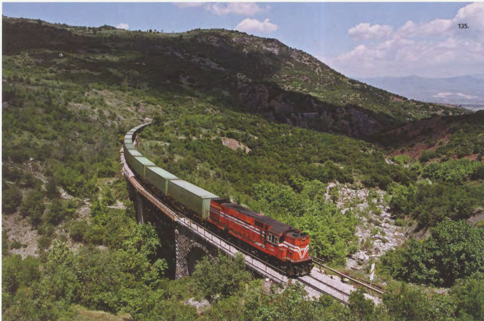
135. - 138. | Μετά την Στάση Τραχίνας, η βραχοπλαγιά της Οίτης χαμηλώνει και το τοπίο γίνεται πιο ανοιχτό και ήπιο. Εδώ κατεβαίνει ο Ξεριάς που για να τον γεφυρώσουν οι μηχανικοί κατασκεύασαν (χθ. 211+202) ένα ακόμη κομψό, καμπυλωτό γεφύρι ανοίγματος 40μ. Αποτελείται από ένα μονό μεταλλικό ζευκτό που αρχικά στηρίζονταν σε δύο αψιδωτά, λίθινα ακρόβαθρα, το βόρειο εκ των οποίων έχει μεταπολεμικά αντικατασταθεί με μικρό, ευθύγραμμο ζευκτό. 18.5.2006. Ν. Παπαλέτσος. 1.9.2013. Ι. Ζώρζος.
