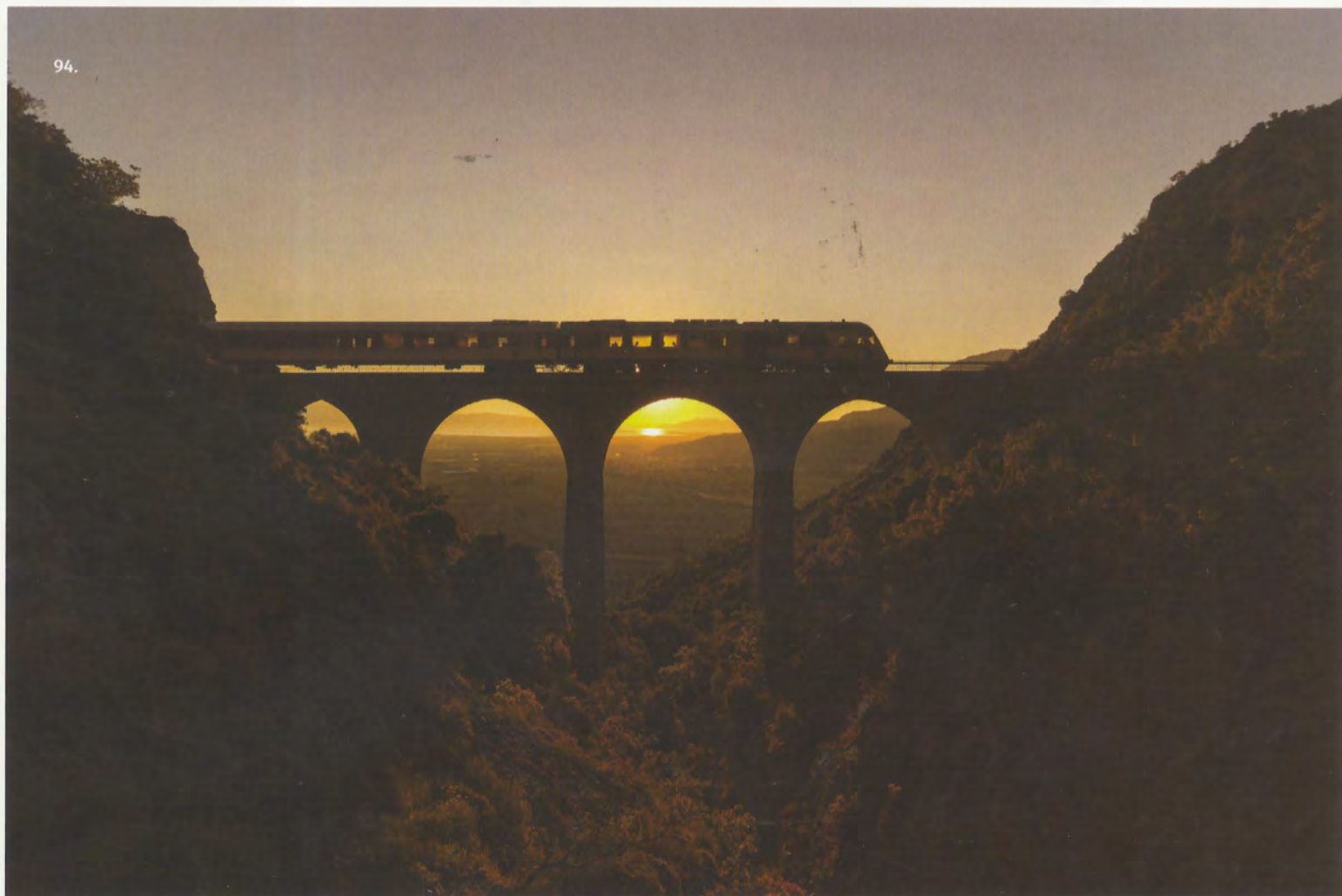
94. - 99. | Με άνοιγμα 52μ. και ύψος 18μ. το 5τοξο γεφύρι είναι και αυτό χαρακτηριστικό δείγμα της τέχνης των μηχανικών που κατασκεύασαν τη γραμμή. Από εδώ, όσοι ταξιδεύουν με το τρένο έχουν απεριόριστη θέα του κάμπου της Λαμίας, των εκβολών του Σπερχειού και του Μαλλιακού, θέα ιδιαίτερα μαγευτική όταν ξημερώνει. 16.8.2016 Κ. Κακαβάς, 7.4.2006. Κ. Κακαβάς.
