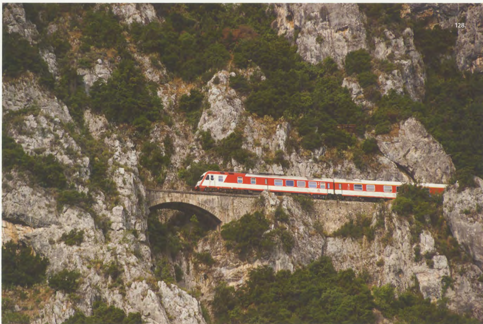
128. & 129. | Στο άκρο της Στάσης Τραχίνας, κοντά στο χωριό Βαρδάτες (χθ. 210+300), ένα κομψό μονότοξο, λίθινο γεφύρι ανοίγματος 12μ. 7.6.2008 Ν. Καντήρης. 20.7.2008. Κ. Κακαβάς.
