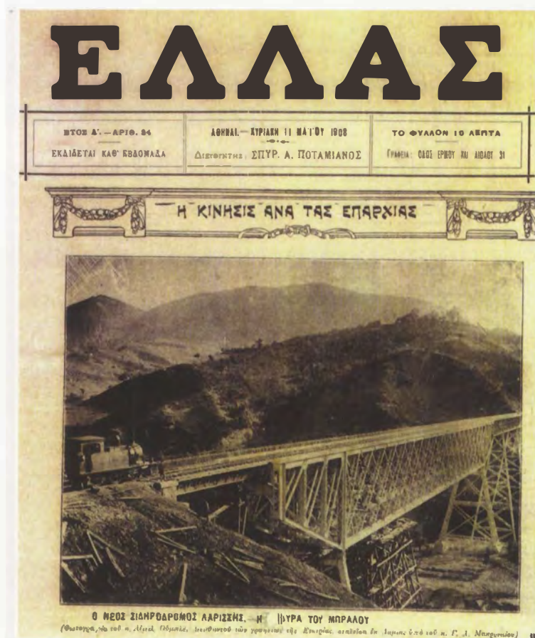
Σ. | Πρωτοσέλιδο της εβδομαδιαίας εφημερίδας «ΕΛΛΑΣ» (φύλλο 24, 11 Μαΐου 1908) όπου απεικονίζεται πλέον έτοιμη η γέφυρα της Παπαδιάς. Αριστερά, η μία από τις δύο ατμάμαχες έργων Etat (μετέπειτα ΣΕΚ Γα 21-22) (συλλογή Ν. Τσίτσα). First-page report on the completion of Papadia viaduct. On the left, one of the two "Etat" works loco (later on SEK Class Ga21-22). Newspaper "Ellas", 11 May 1908. (coll. N. Tsitsas).
