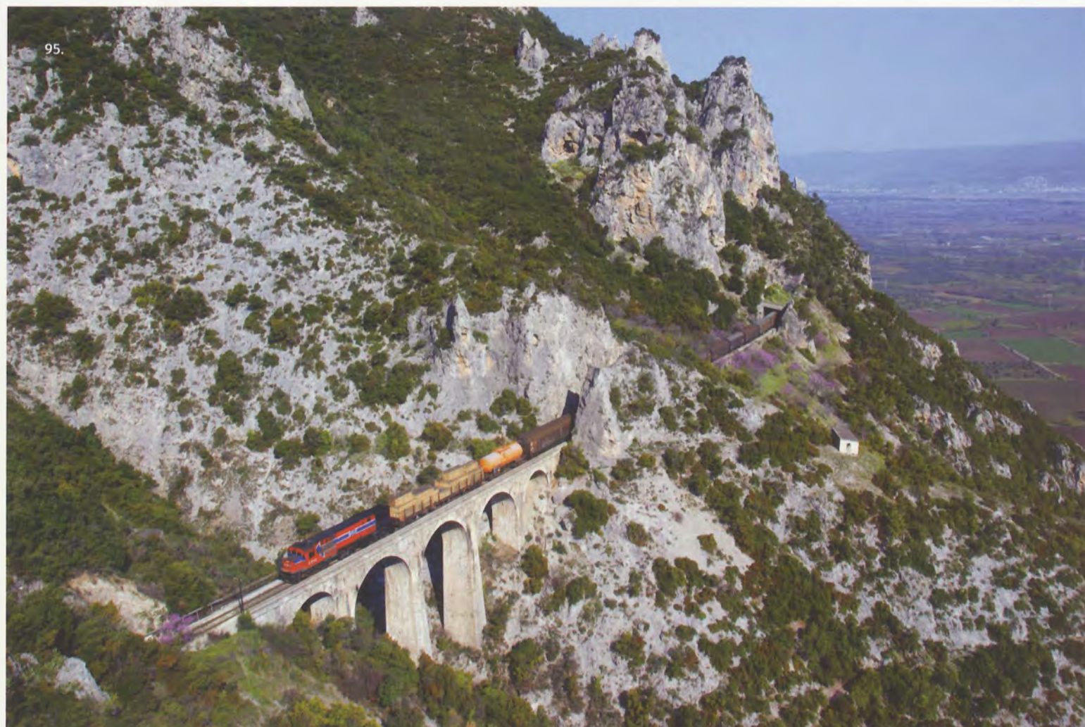
94. - 99. | Με άνοιγμα 52μ. και ύψος 18μ. το 5τοξο γεφύρι είναι και αυτό χαρακτηριστικό δείγμα της τέχνης των μηχανικών που κατασκεύασαν τη γραμμή. Από εδώ, όσοι ταξιδεύουν με το τρένο έχουν απεριόριστη θέα του κάμπου της Λαμίας, των εκβολών του Σπερχειού και του Μαλλιακού, θέα ιδιαίτερα μαγευτική όταν ξημερώνει. 16.8.2016 Κ. Κακαβάς, 7.4.2006. Κ. Κακαβάς.
