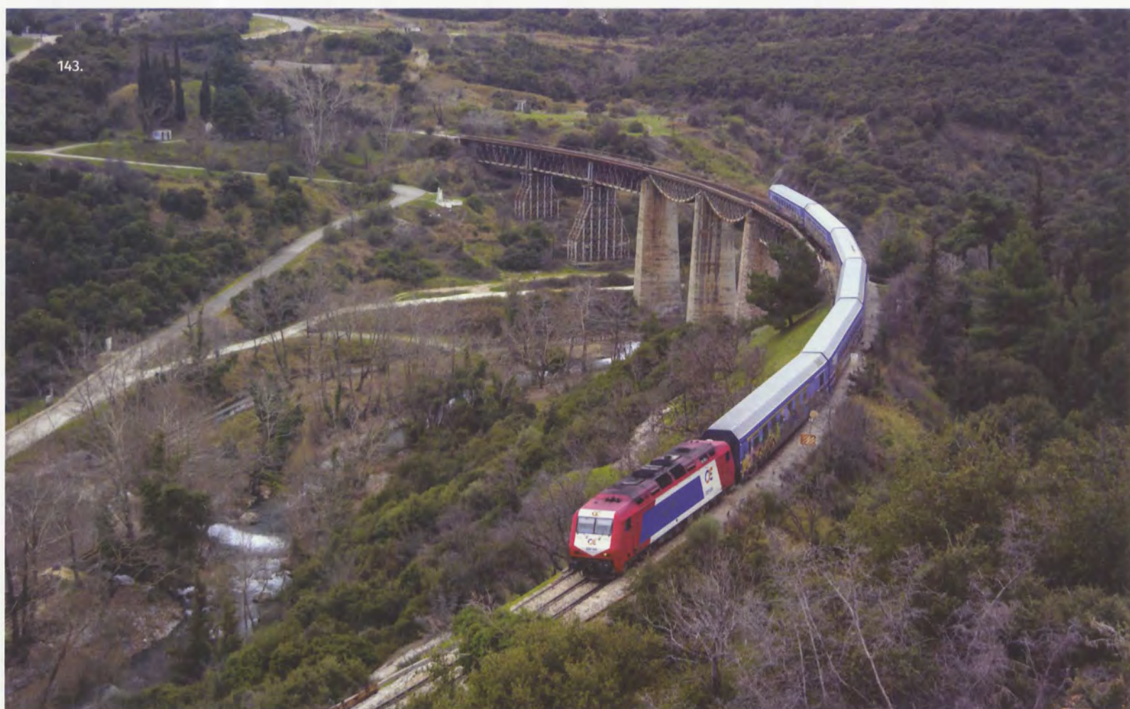
143. & 144. | Γεφυρώνοντας τον Γοργοπόταμο στη χ.θ. 214+720, η καμπυλωτή κατασκευή με τα 6 μεσόβαθρα και 7 μεταλλικά ζευκτά, έχει χάσει την αρχική της μορφή, μετά την ανατίναξη της το 1942 και τη καταστροφή της από τους υποχωρούντες Γερμανούς το 1944. 2.3.2013 Ι. Ζώρζος, 14.6.2015 Γ. Καρυοφύλλης.
