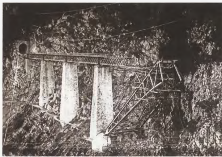
Σ. | Η κατασκευή της γέφυρας Ασωπού. Διακρίνονται τα προς τον Πειραιά ακρόβαθρα και το πρώτο τμήμα του τριαρθρωτού τόξου (συλλογή Γ. Χανδρινού). Construction of Asopos bridge (south section) (coll. G. Handrinos).
