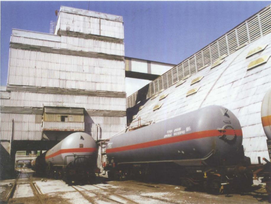
Σ. | Βυτία μεταφοράς άνυδρης αμμωνίας των ΒDZ στο χώρο της «Βιομηχανίας Φωσφορικών Λιπασμάτων» ( 9 Οκτ. 2000 - Γ. Χανδρινός)
