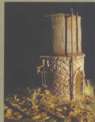
Υδατόπυργος Καλού Νερού
