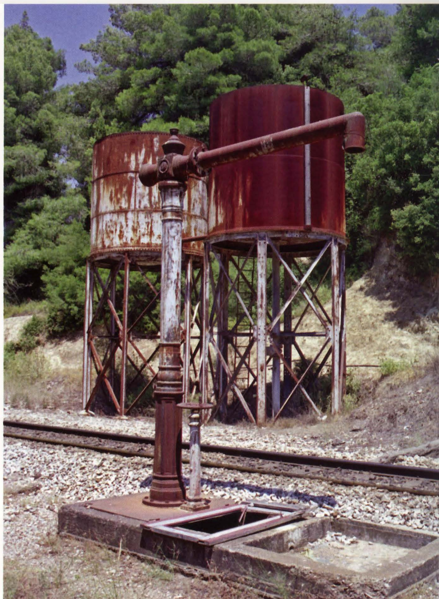
Το πλήρες συγκρότημα ύδρευσης στο σταθμό της Αλφειούσας στην Ηλία. Η παροχή νερού γίνεται από τον παρακείμενο ποταμό Αλφειό.
