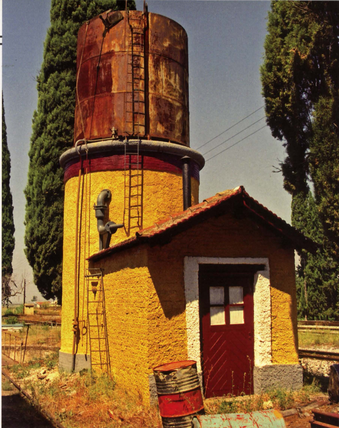
Υδατόπυργος Βεθεστίνου. Εντός του οικήματος διασώζεται η αμμοκίνητη αντλία ύδρευσης των ατμομηχανών.
