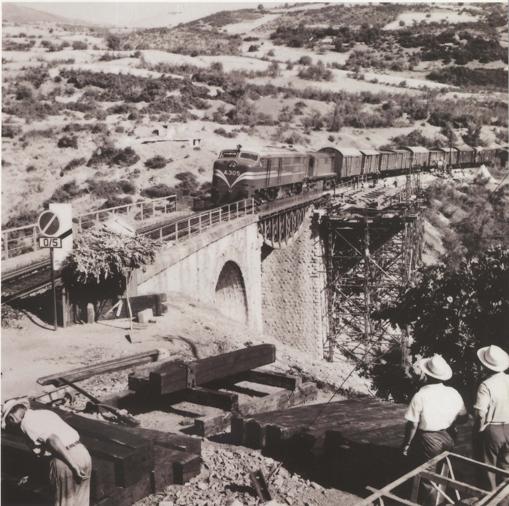
Έργα ενίσχυσης της γέφυρας στην κ.θ. 211.202. μεταξύ Τραχίνας και Αρπίνης. Επικεφαλής της διερχόμενης εμπορικής αμαξοστοιχίας οι νητζελόμαξες ALCO A. 305 + A.200 (1962.).
