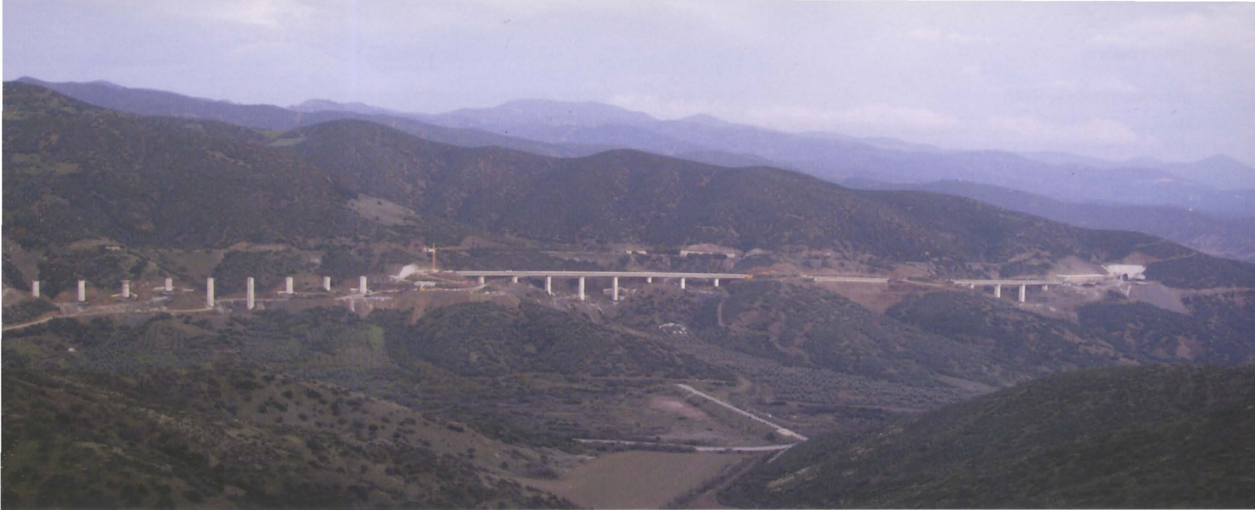
Γενική άποψη των έργων πριν την σήραγγα της Όρθρους. Φωτογραφία Μιχάλης Ανοστοσάκης.
