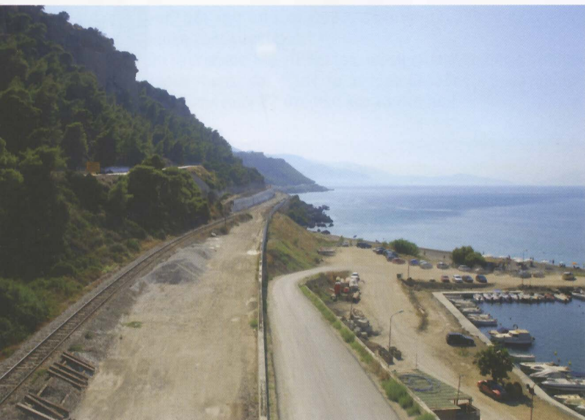
Αποψη των έργων στην περιοχή του Ποταμίτικου γαλαού, λίγο πριν τον Πλάτανο Αιγαλείας. Φωτογραφία Γρηγόρης Καραθανάσης.
