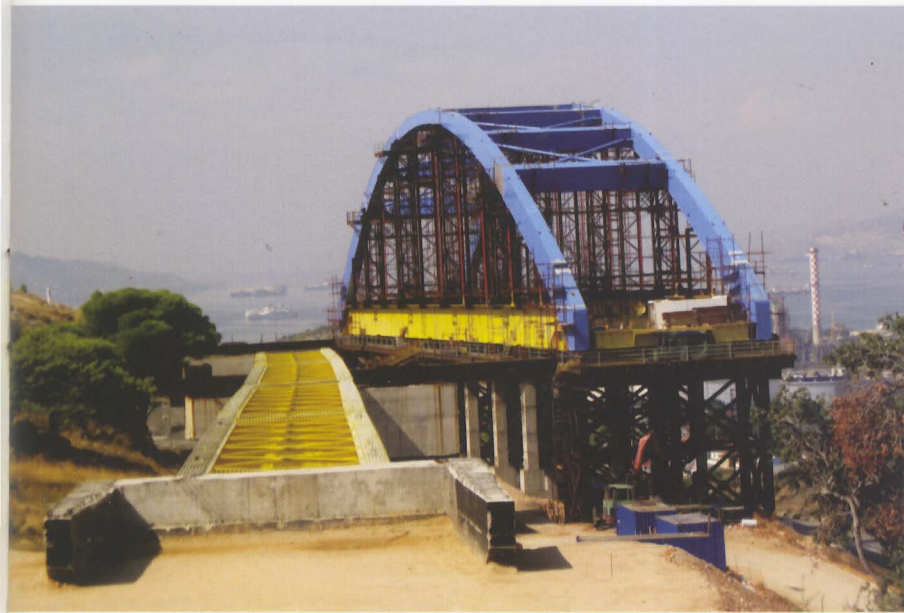
Γέφυρα Κατολισθησης στην γραμμή Ικονίου. Φωτογραφία Μιχάλης Αναστασάκης.
