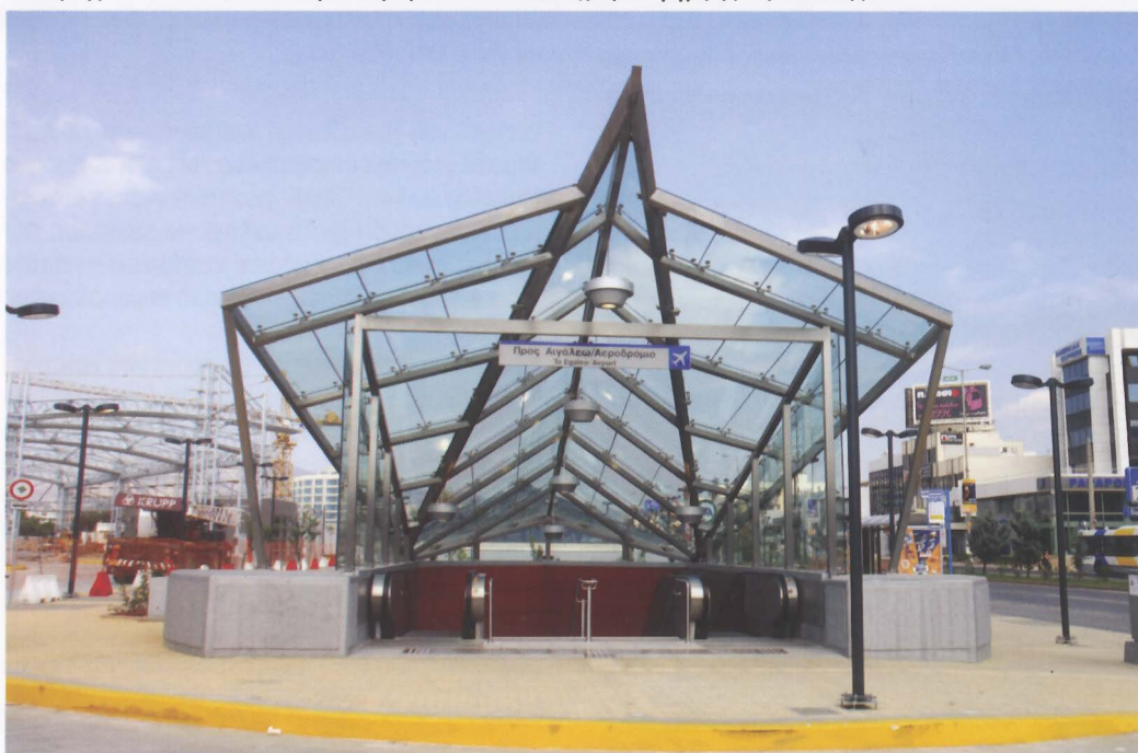
Άποψη της εισόδου του νέου σταθμού Νομισματοκοπείο. Φωτογραφία: Γρηγόρης Καραθανάσης
