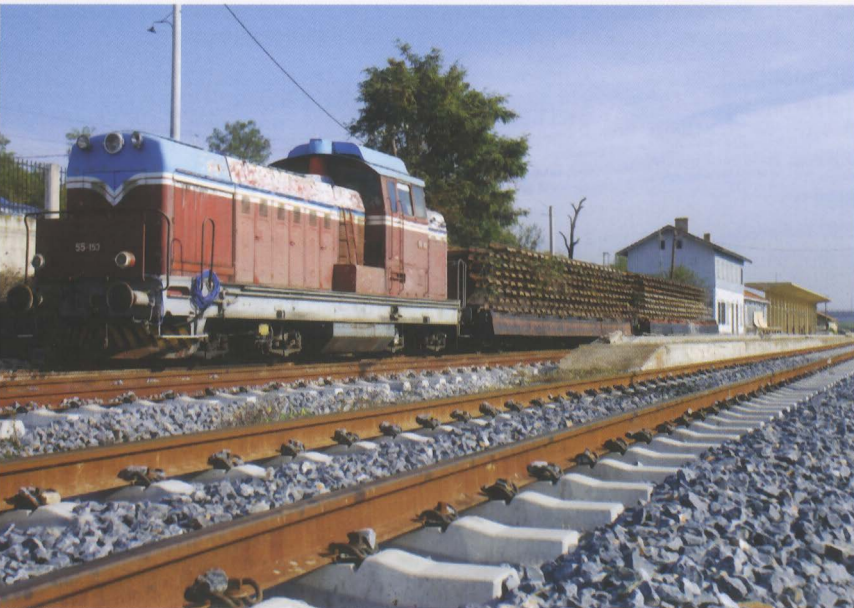
Η Δηζελάμαξα 44 153 κατασκευής FauI στο σταθμό Διδυμοτείχου με συρμό έργων για τις εργασίες ανακατασκευής της γραμμής. Φωτογραφία Γρηγόρης Καραθανάσης.
