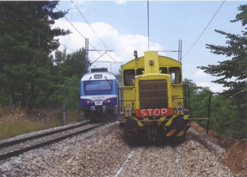
Από τις εργασίες βύθισης της γραμμής στην περιοχή της Σφενδάλης. Φωτογραφία Γρηγόρης Καραθανάσης.
