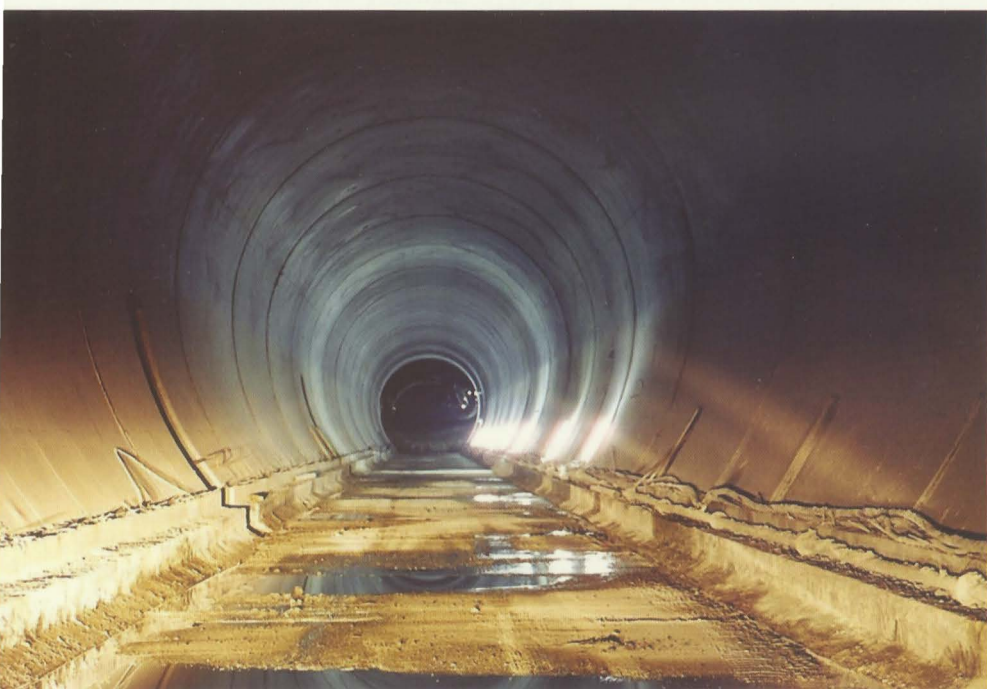
Τμήμα Τιθορέα - Λειανοκλάδι. Άποψη του εσωτερικού της σήραγγας του Καλλιδρόμου με τη μόνιμη επένδυσή της. Φωτογραφία: Γρηγόρης Καραθανάσης.
