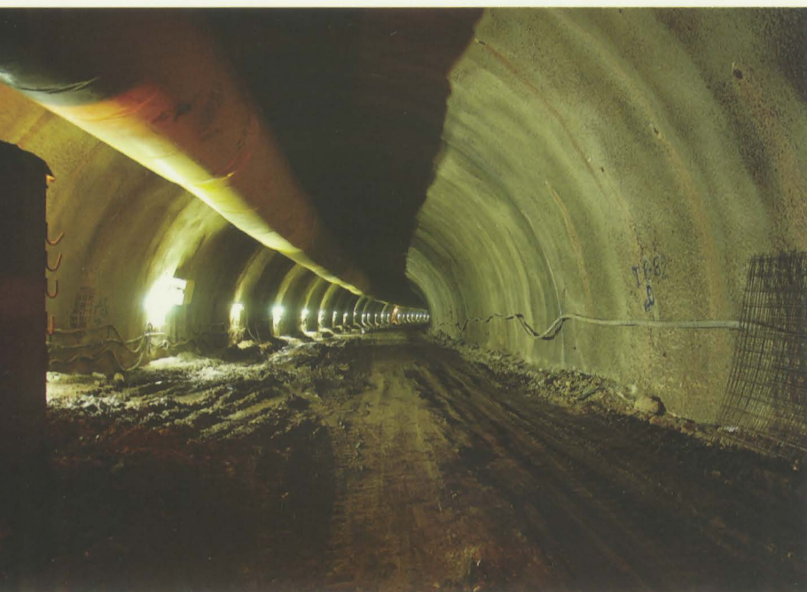
Τμήμα Λειανοκλάδι - Δομοκός. Εσωτερικό της σήραγγας Σ.Σ.6. Φωτογραφία: Μανώλης Τζεβελεκάκης.
