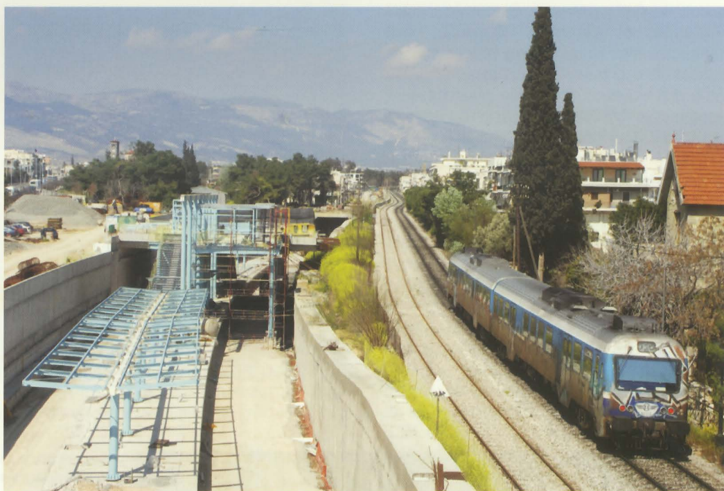
Τμήμα Τρεις Γέφυρες - Σ.Κ.Α. Σταθμός Αγ. Αναργύρων σε προχωρημένο στάδιο εργασιών. Φωτογραφία: Γρηγόρης Καραθανάσης.
