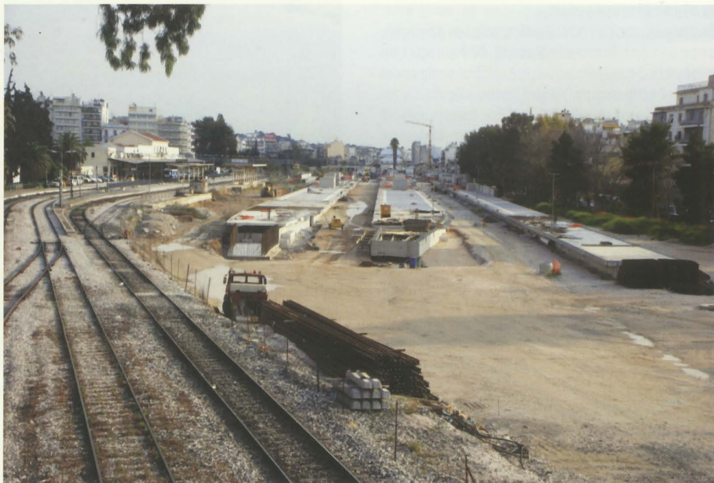
Τμήμα Πειραιάς - Τρεις Γέφυρες. Αποψη των εργασιών στο βόρειο άκρο των νέων αποβάθρων του Σ.Σ. Αθηνών, και όπως αυτές διαμορφώνονται. Φωτογραφία: Γρηγόρης Καραθανάσης.
