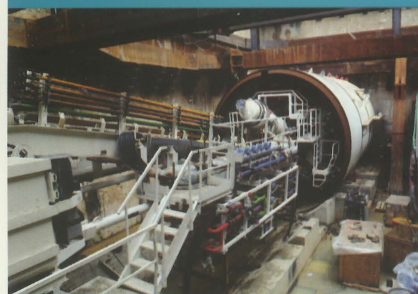
Συναρμολόγηση του ΤΒΜ2. Το εμπρόσθιο μέρος έχει είδη συναρμολογηθεί και βρίσκεται εντός της στοάς, Φεβρουάριος 2009, Φωτογραφία: Νίκος Παπαλέτσος
