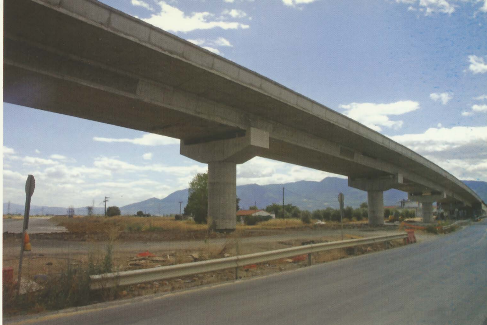
Τμήμα Τίθορα - Λειανοκλάδι. Γέφυρα της Π.Ε.Ο. στο Κομμα Λαμίας. Φωτογραφία: Γρηγόρης Καραθανάσης.
