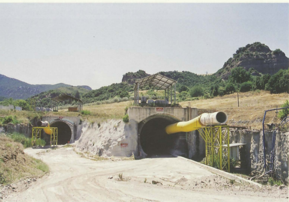
Τμήμα Τιθορέα - Λειανοκλάδι. Βόρεια έξοδος σήραγγας καλλιδρόμου. Φωτογραφία: Γρηγόρης Καραθανάσης.
