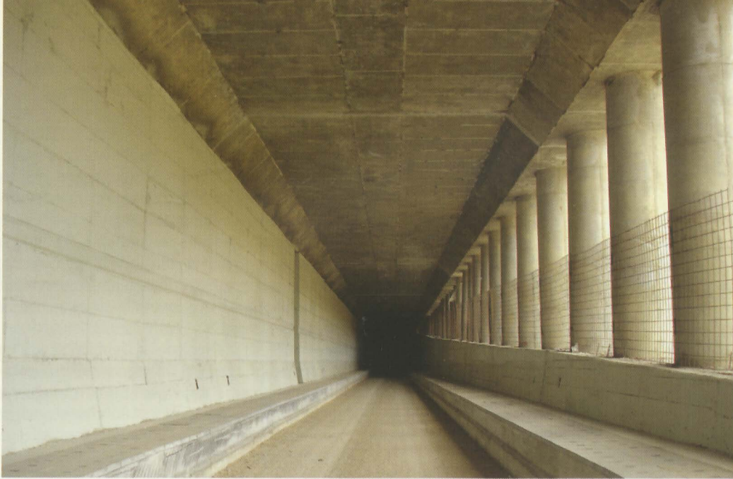
Γραμμή Ικονίου. Cut & cover Λεωφόρου Σχιστού. ΕΡΓΟΣΕ-ΕΡΓΑ 1
