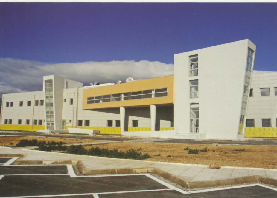
Εμπορευματικός Σταθμός Θριασίου. Αποψη του κτηρίου του αμαξοστασίου στο Θριάσιο. Φωτογραφία: Μανώλης Τζεβελεκάκης.
