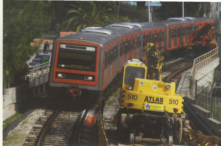
Ανακαίνιση γραμμής ΗΣΑΠ. Από την ανακαίνιση της γραμμής του ΗΣΑΠ, λίγο πριν τον σταθμό της Ειρήνης. Φωτογραφία: Γρηγόρης Καραθανάσης.
