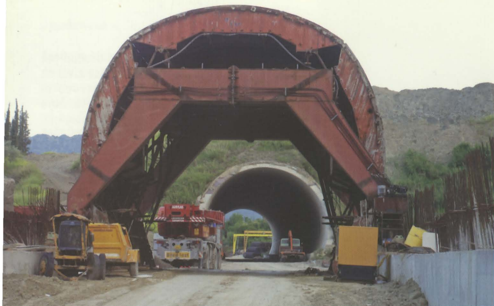
Τμήμα Τιθορέα - Λειανοκλάδι. Κατασκευή cut & cover πριν τη γέφυρα στο Ρεγγίνιο. Φωτογραφία: Γρηγόρης Καραθανάσης.
