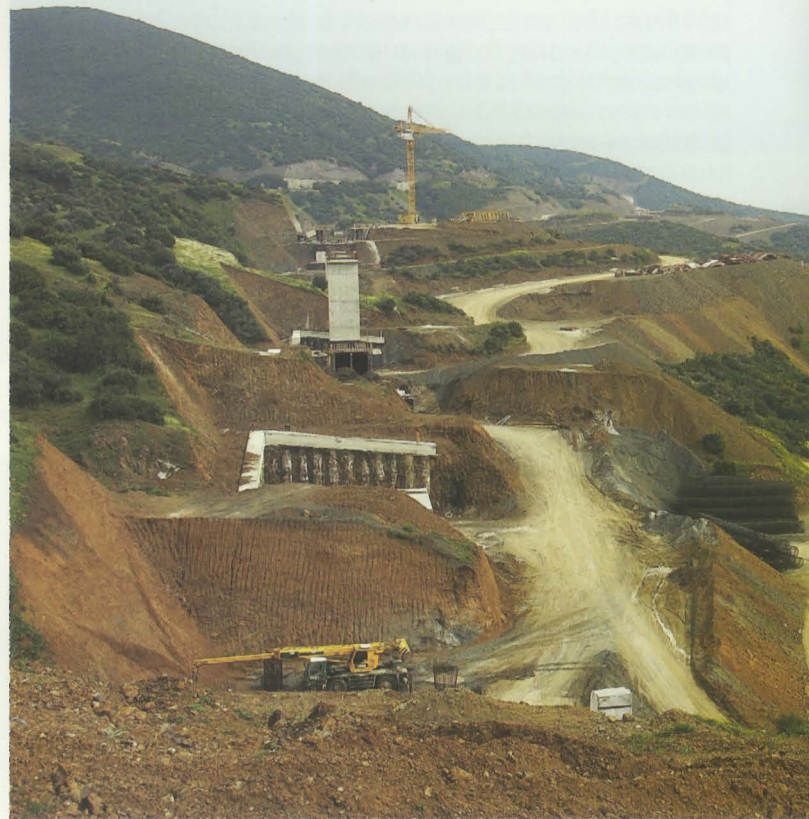
Τμήμα Λειανοκλάδι - Δομοκός. Γενική άποψη της γέφυρας Σ.Γ.15. Φωτογραφία: Μανώλης Τζεβελεκάκης.
