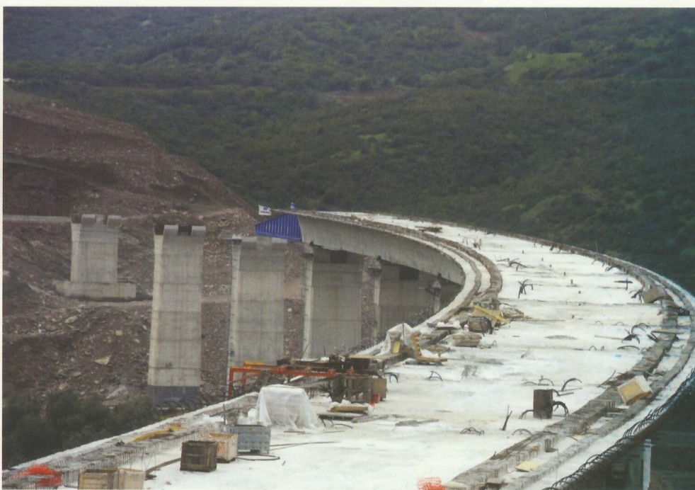
Τμήμα Λειανοκλάδι - Δομοκός. Γενική άποψη της γέφυρας ΣΓ 10. Φωτογραφία: Μανώλης Τζεβελεκάκης.
