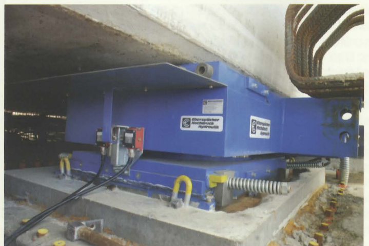
Τμήμα Λειανοκλάδι - Δομοκός. Εφεδρανα ολισθησης κατά τη στιγμή προώθησης τμήματος της γέφυρας ΣΓ 10. Φωτογραφία: Γρηγόρης Καραθανάσης.
