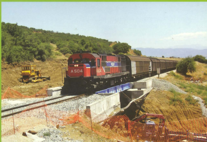
Παράλληλη της παλαιάς γραμμής στα έργα του Καλιδρόμου. (φωτ. Γιώργος Γεωργίου)
