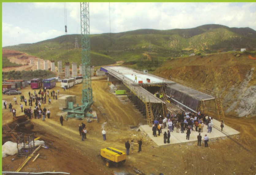
ΣΓ10. Κατασκευή γέφυρας με προώθηση. (φωτ. Μάνος Τζεβελεκάκης)
