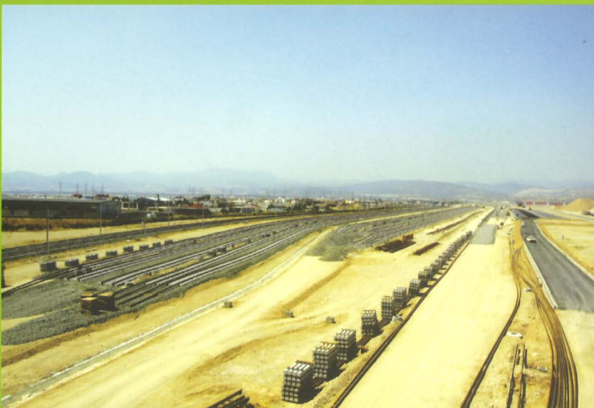
Από την εξέλιξη των έργων στο ΣΚΑ (φωτ. Μάνος Τζεβελεκακης)
