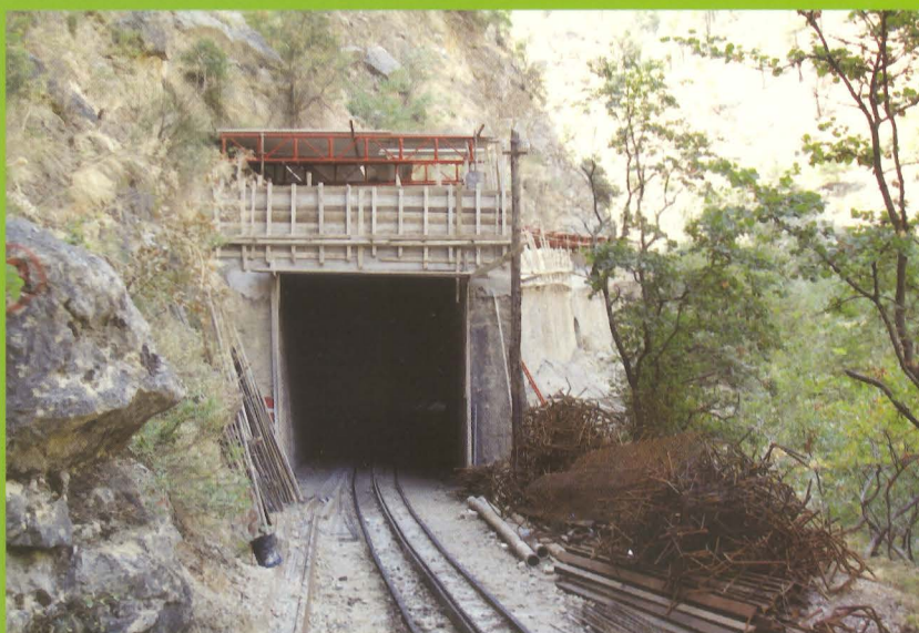
Τα έργα της αντικατολισθητικής σήραγγας του Οδοντωτού. (φωτ. Χρήστος Ζαχαρίας)
