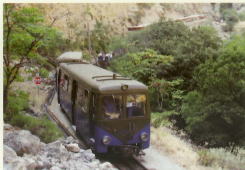
Από την επίσκεψη στα έργα της αντικατολισθητικής σήραγγας. (Φωτ. Χρήστος Ζαχαρίας)
