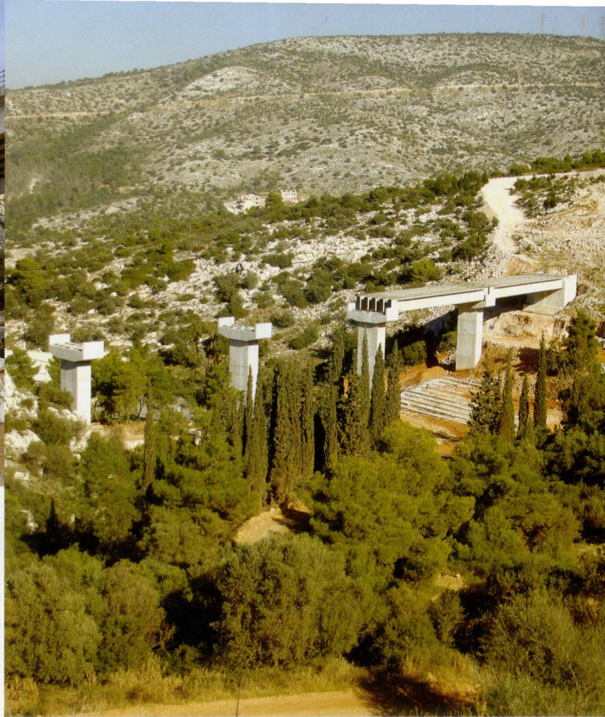
Κοιλαδογέφυρα 143μ, υπό κατασκευή στην περιοχή Σκαρμαγκαλά
