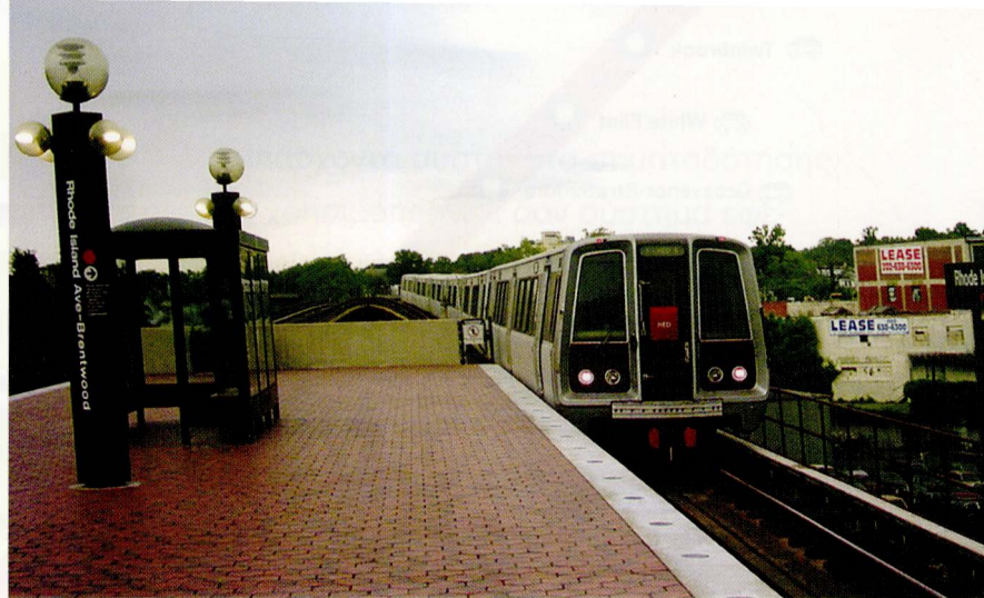
Εξόδομος συρμός αναχωρεί από τον σταθμό Rhode Island Avenue-Brentwood
