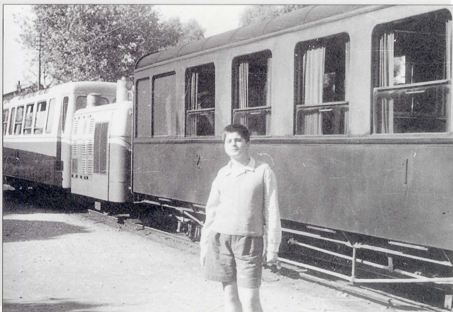
A/A Billard σε σύνθεση με την επιβατάμαξα Β131, στον παλιό σταθμό Διακοφτού (Πάσχα 1963, Λοχείο Γ. Νάθενα)
