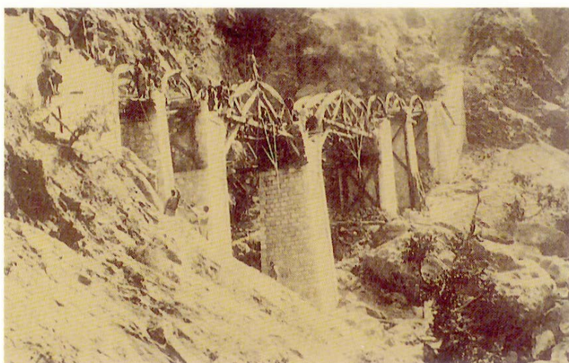
Από τις εργασίες κατασκευής των τεχνικών έργων (Αρχείο Ι. Ζαχαλαούδη)
