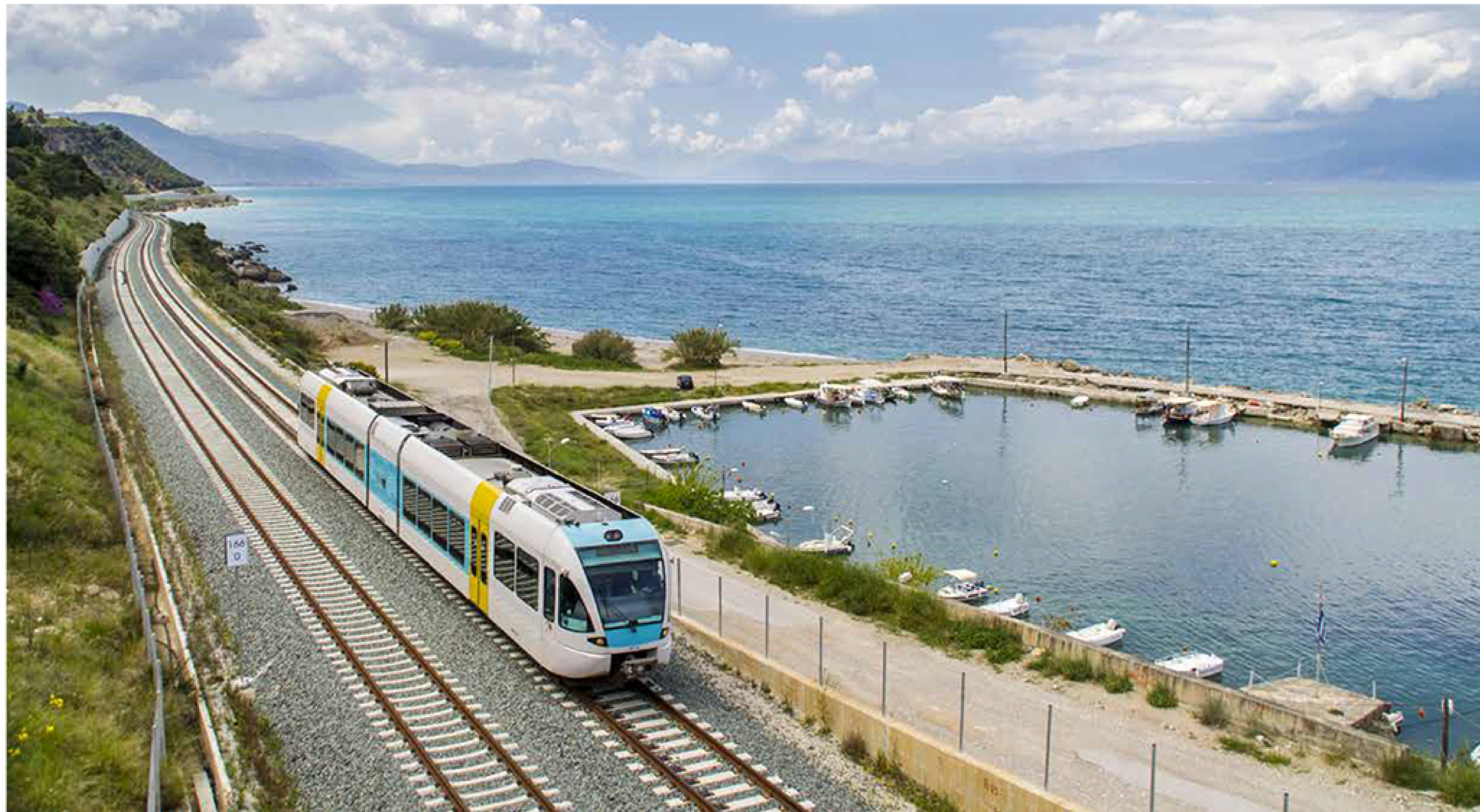
Μία αυτοκινητάμαξα τύπου "Rail bus" διέρχεται από την περιοχή της Ακράτας, εκτελώντας το πρώτο δοκιμαστικό δρομολόγιο στην νέα γραμμή υψηλών ταχυτήτων Κιάτου – Αγίου. Φωτογραφία: Θάνος Αβδουλάς
