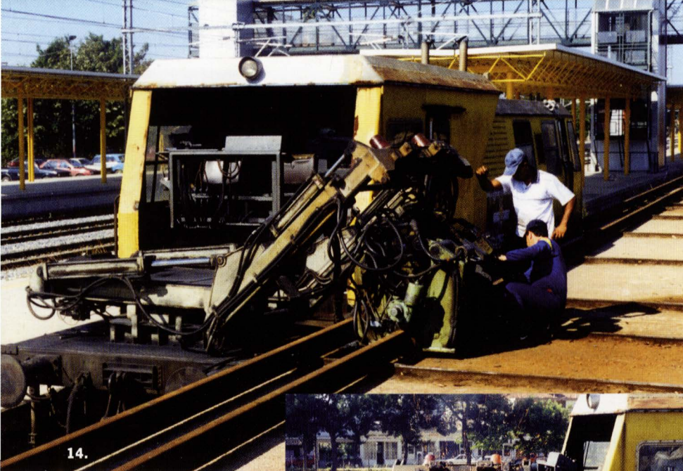
14. Διαδικασία ηλεκτρικής συγκόλλησης: Ευθυγράμμιση των σιδ/χιών με την βοήθεια των αρπαγών του μηχανήματος.
