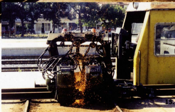
15. Εκτέλεση ηλεκτρικής κόλλησης: Την στιγμή αυτή το μηχάνημα K355APT του ΟΣΕ, εξοπλισμένο με ρωσικής κατασκευής κεφαλή συγκόλλησης, διοχετεύει στις σιδηροτροχιές ηλεκτρικό ρεύμα έντασης μέχρι και 10000 Amps.
