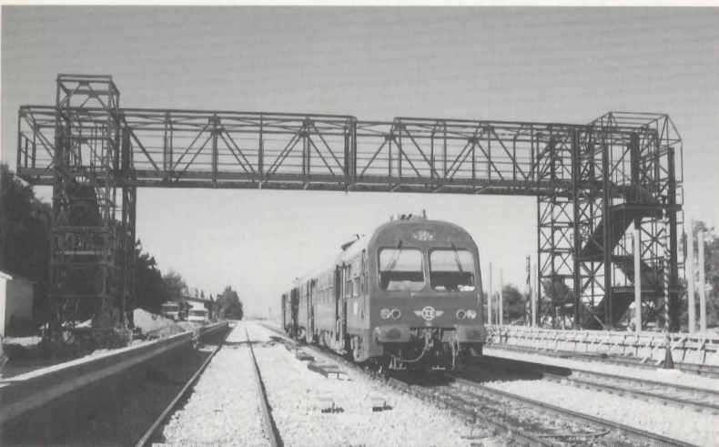
Κατασκευή ανισόπεδης πεζοδιάβασης στο σταθμό της Σίνδου.
