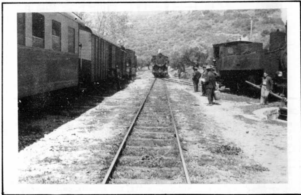
Σταθμός Αχλαδοκάμπου: Διασταύρωση δύο ατμηλάτων αμαξοστοιχιών ενώ δεξιά διακρίνεται η ατμάμαξα ωθήσεως Ζ ο . Φωτογραφία: Δ. Μεταξάς
